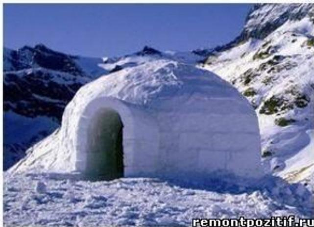
Представляет собой зимнее жилище часто в виде полусферического купола диаметром 3—4 метра и высотой около 2 метров из уплотнённых ветром снежных или ледяных блоков. При глубоком снеге вход обычно устраивается в полу, ко входу прорывается коридор. При неглубоком снеге вход устраивается в стене, к которой достраивается дополнительный коридор из снежных блоков. Важно, чтобы вход в иглу был
